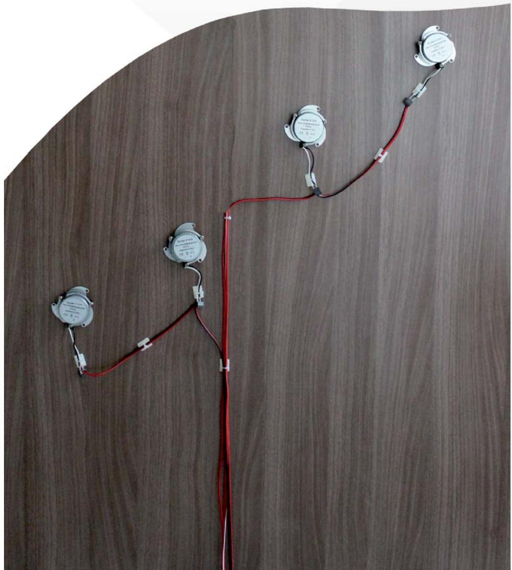
Rückseitenansicht Lamellenwand mit installiertem Spacewall® OPERA - System
